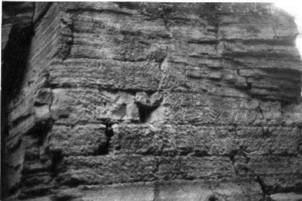
Große Teile dieser Felswände zeigen heute immer noch prägnante Schraffuren, die nur mit Meißel, Spitzhacke oder dem Zweispitzhammer der Steinbrucharbeiter entstanden sein können (Bild 9). Der Zweispitz wurde bei der sogenannten Schrotgrabenmethode verwendet. Diese Methode ist uralt.
